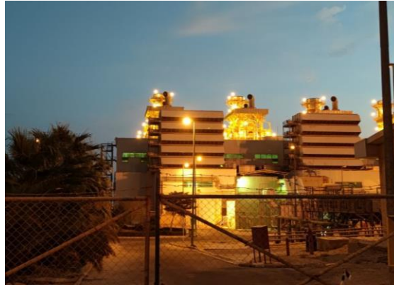
نمای کلی نیروگاه
